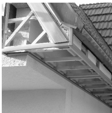
osazené ukončovací profily a 1. lamela
